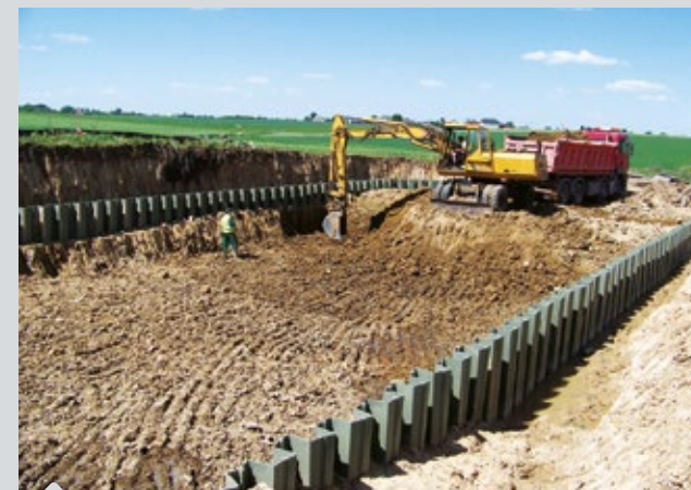
Buffer bassin bij snelweg.
