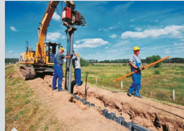
Waterdicht maken van dijk tegen overstromingen.
