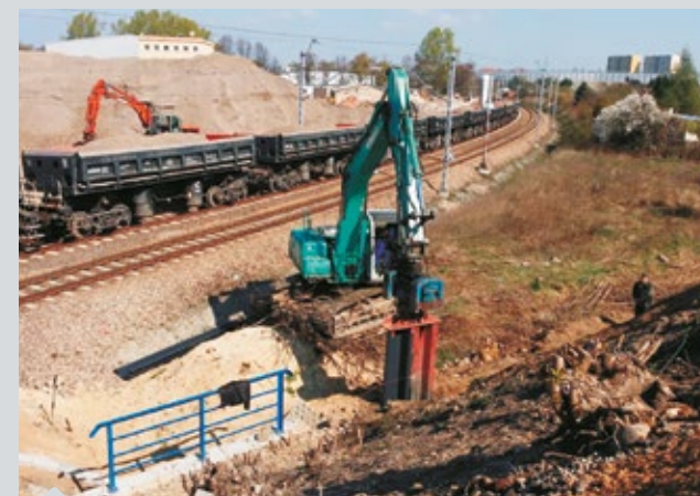
Modernisering van de spoorlijn.
