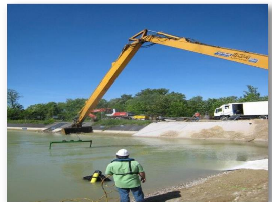
Aanleg met begeleiding door duikers onder water
